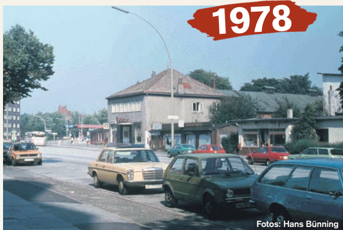
Nicht nur der Ose-Palast ist geräumt, auch die angrenzende Baracken wurden 1978 zum Abbruch für das neue Legiencenter vorbereitet
