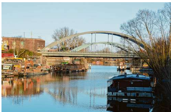
Die alte Stahlkonstruktion musste durch eine neue ersetzt werden
