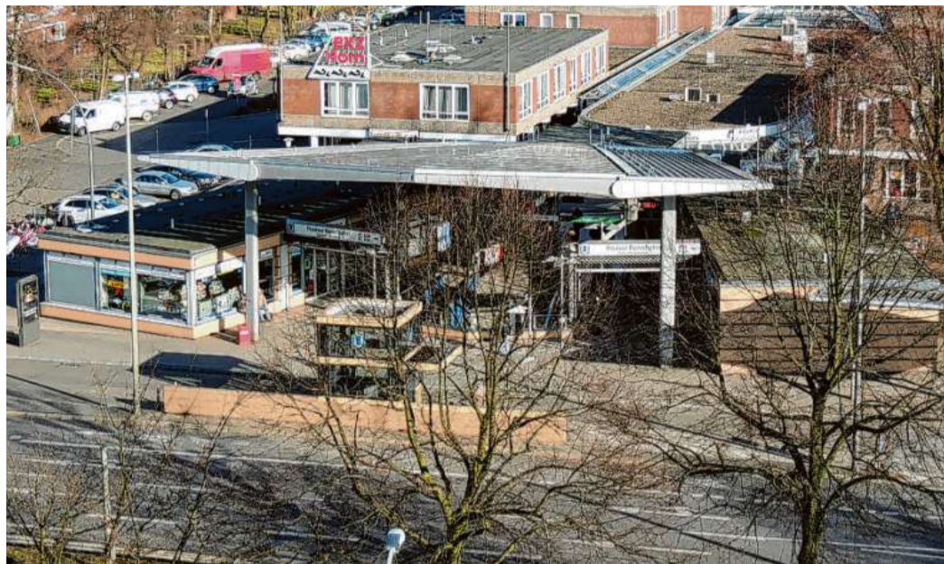
Der alte U-Bahnhof im Juni 1999 kurz vor dem Abbruch
