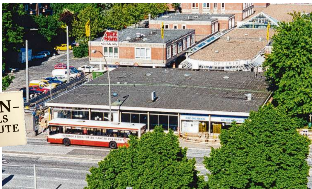
Am 1. Dezember 2000 wurde der Neubau eingeweiht
